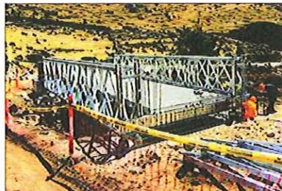
Construcción de un puente modular en Perú.
